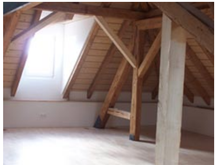
Neuer Ratsaal Innenansicht am 16.09.05
